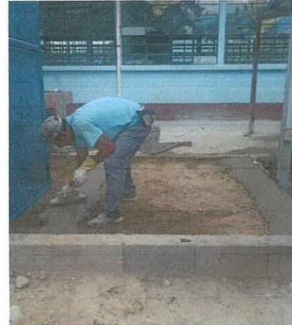
Foto 2: Área en la que se está llevando a cabo el proceso de mejoramiento de la losa de patio en el lado Sur y en la entrada principal del instituto.
