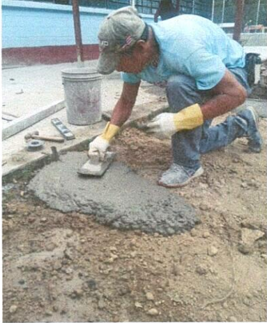
Foto1: Área en la que se está llevando a cabo el proceso de mejoramiento de los 80 metros cuadrados de la losa de patio del lado Sur.
