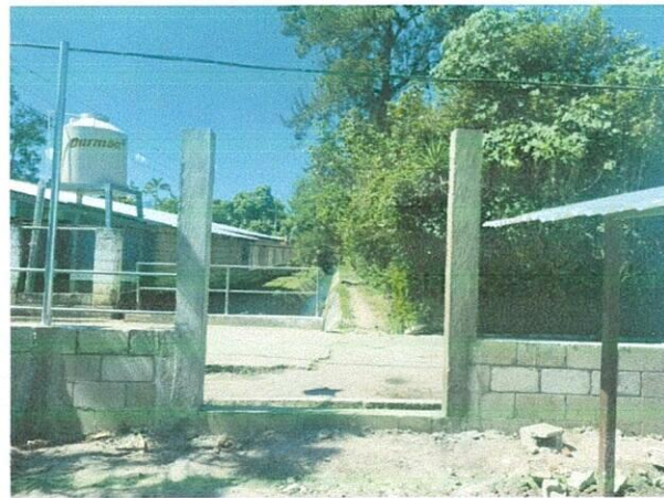
Foto 2: Área en la que se está llevando a cabo el mejoramiento y la instalación de un portón metálico en el lado Sur del cerramiento perimetral
