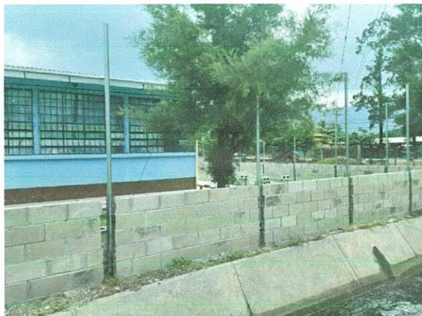
Foto 1: Área en la que se está llevando a cabo el proceso de remozamiento del cerramiento perimetral, específicamente en los lados Sur y Norte del espacio.
